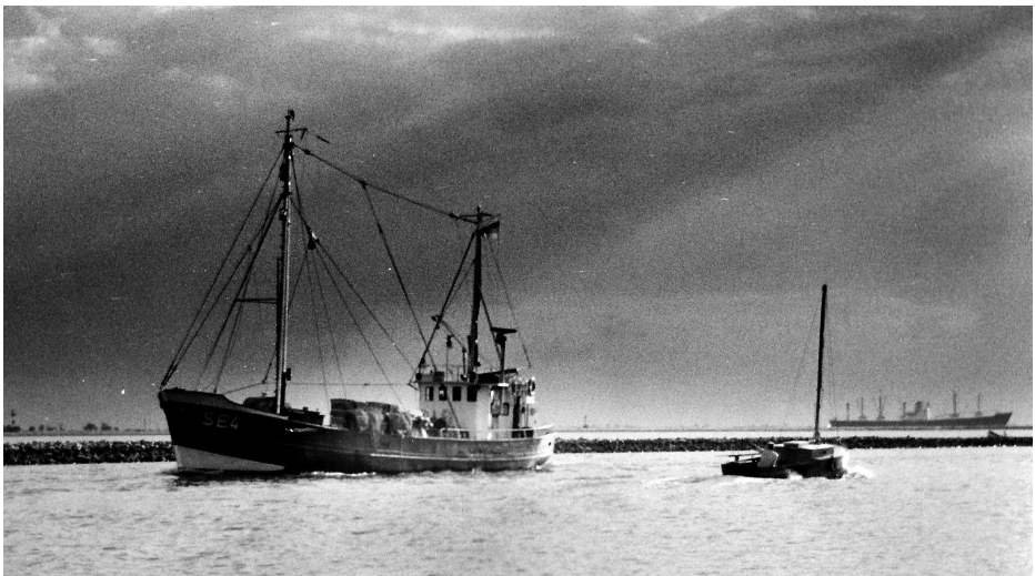
Abb. 2: 18-m-Fischkutter KEHRWIEDER (SE 4), Eigner Kurt Karp, Seester, nach der Verlängerung um drei Meter. Foto: Walter Plazcek, Elmshorn. Quelle: Sammlung des Autors.
